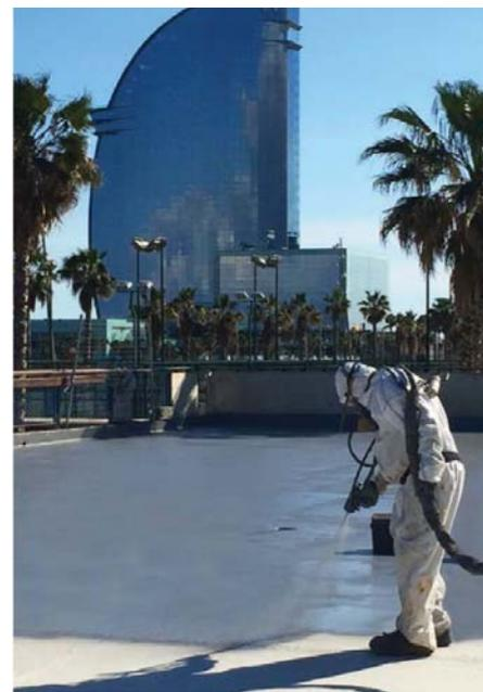
риал, с растяжением более 600%, подходящий для использования на любые поверхности (потолок, стены, пол) и на любое основание (бетон, металл, шифер, рубероид, полиуретановая пена). Имеются различные марки *Tecnocoat* для горячего и холодного нанесения. Время высыхания от 3 до 25 секунд, гарантия на материал ETA 25 лет.
