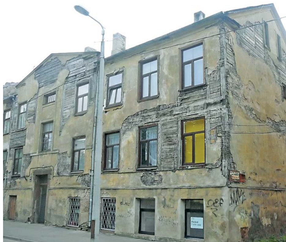
Дом до ремонта.
