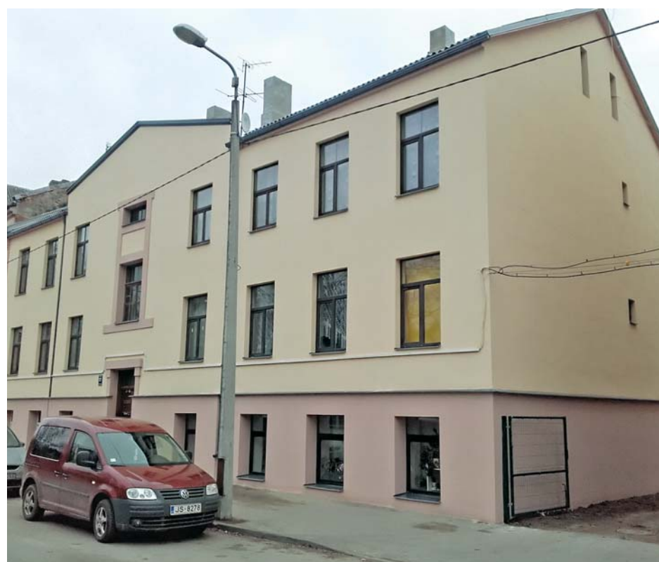
Дом после ремонта.
