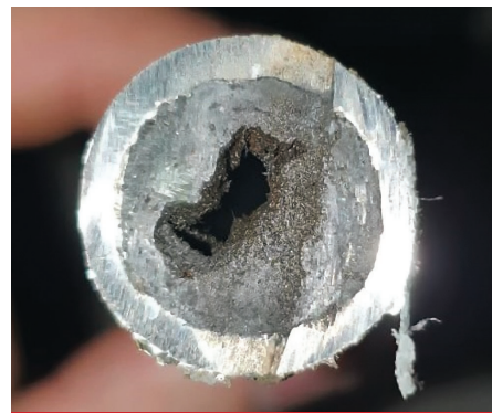
По причине зарастания труб плохо греют полотенцесушители
