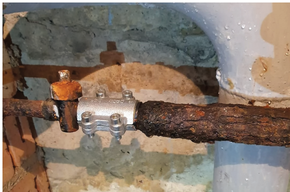
Ржавчина повреждает водопроводные и канализационные трубы, и это самая частая причина прорыва труб
