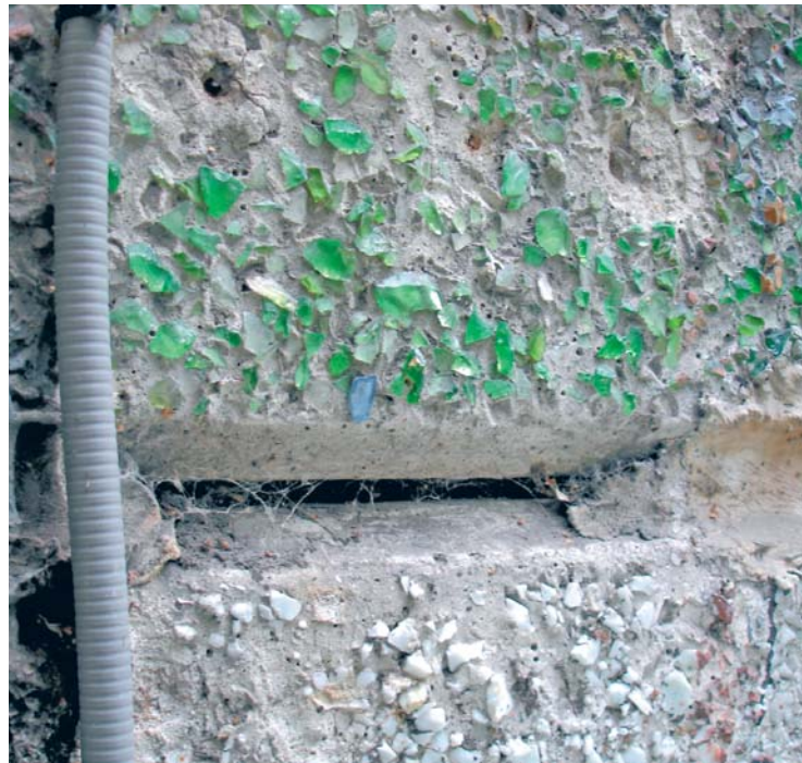
Такой межпанельный шов нуждается в качественной помощи!
