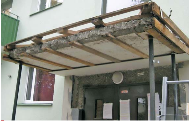
Тяжелый козырек: чтобы не было угрозы обрушения, его укрепили.
