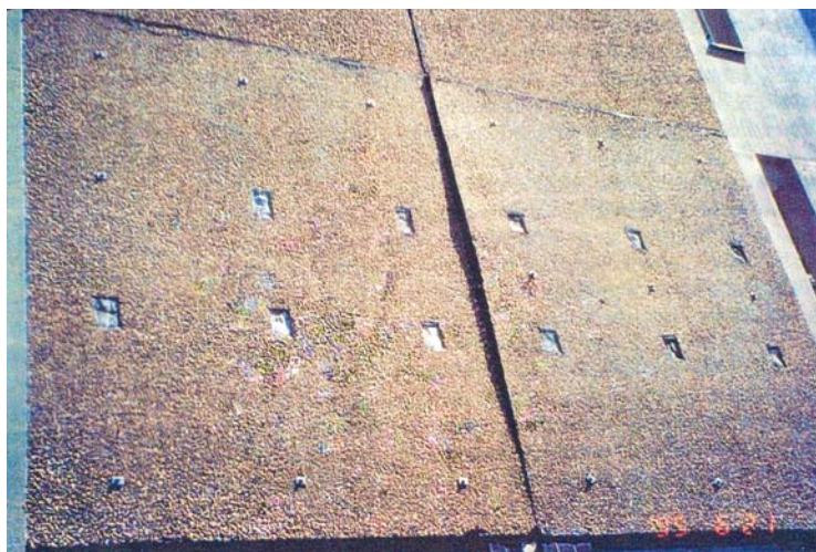
Буквально на честном слове: Отваливающиеся панели в многоквартирном доме.
