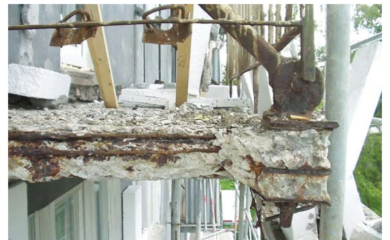
Опасность над головой: иногда балконы находятся в таком ужасном состоянии, что их нужно срочно приводить в порядок, чтобы не случилось трагедии.
